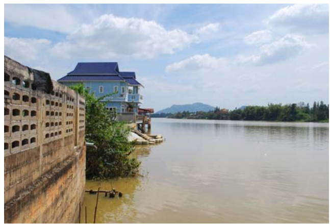
รูปที่ 5.9 การก่อสร้างอาคารรุกล้ำแม่น้ำ
