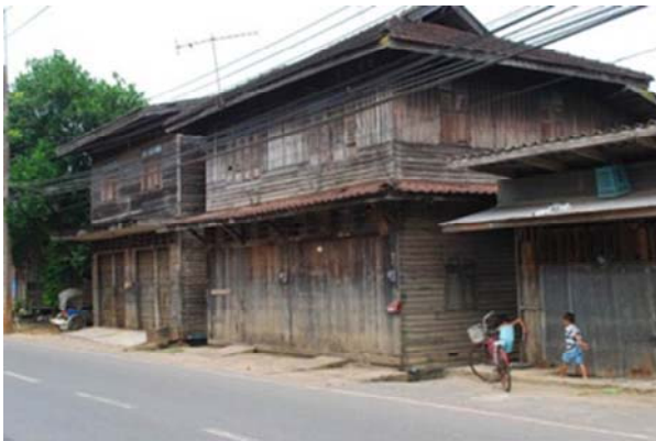
รูปที่ 5.14 การประเมินความสูงระดับน้ำท่วมจากรอยของน้ำที่ปรากฏอยู่บนอาคาร
