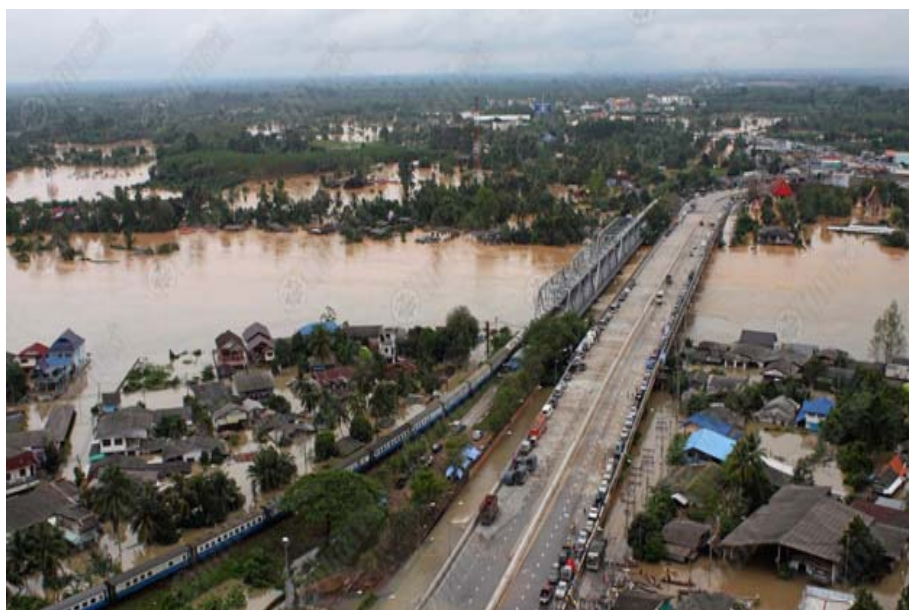
รูปที่ 3.9 น้ำท่วมถนนและทางรถไฟในเขตเมืองพูนพิน
