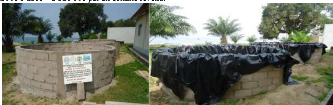
Photo 6: construction d'étangs pour l'élevage de crevettes
