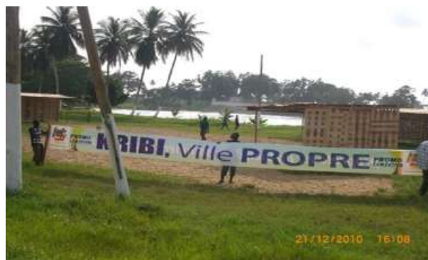
Photo 22: Parc des Expositions en cours de construction
